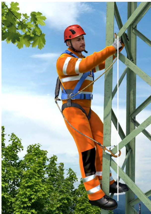
Abb. 5.3.12 Besteigung eines Mastes unter Anwendung der Y-Seil-Methode
