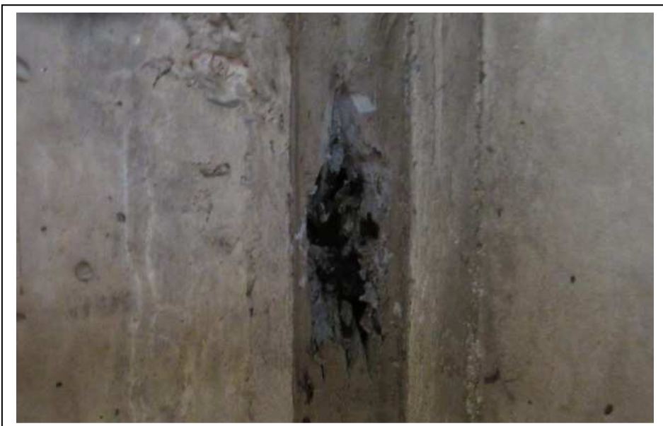
Foto 4: Kellerwand, schwarze Dichtungsmasse hinter grauer Dehnungsfuge (Pr 160124-2)
