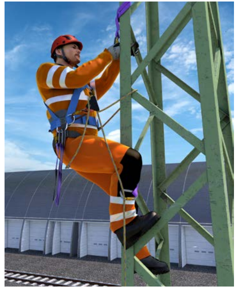
Abb. 5.3.2 1 Besteigung eines Mastes unter Anwendung der Schlaufenmethode
