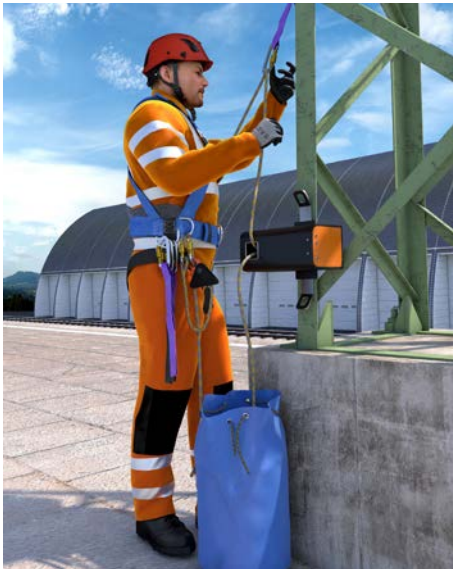
Abb. 5.3.2 1 Besteigung eines Mastes unter Anwendung der Schlaufenmethode
