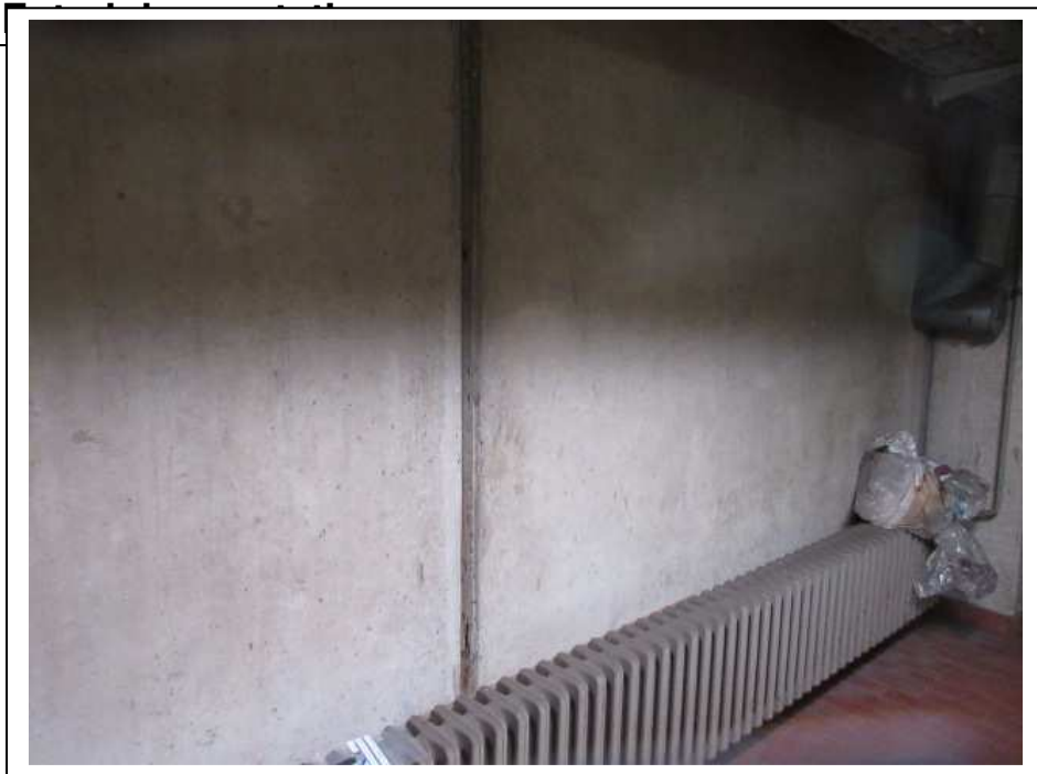
Foto 3: Keller Reparaturhalle Außenwand zum Anbaubereich UFD; Dehnungsfuge, grau u. weich (Pr 160124-1)
