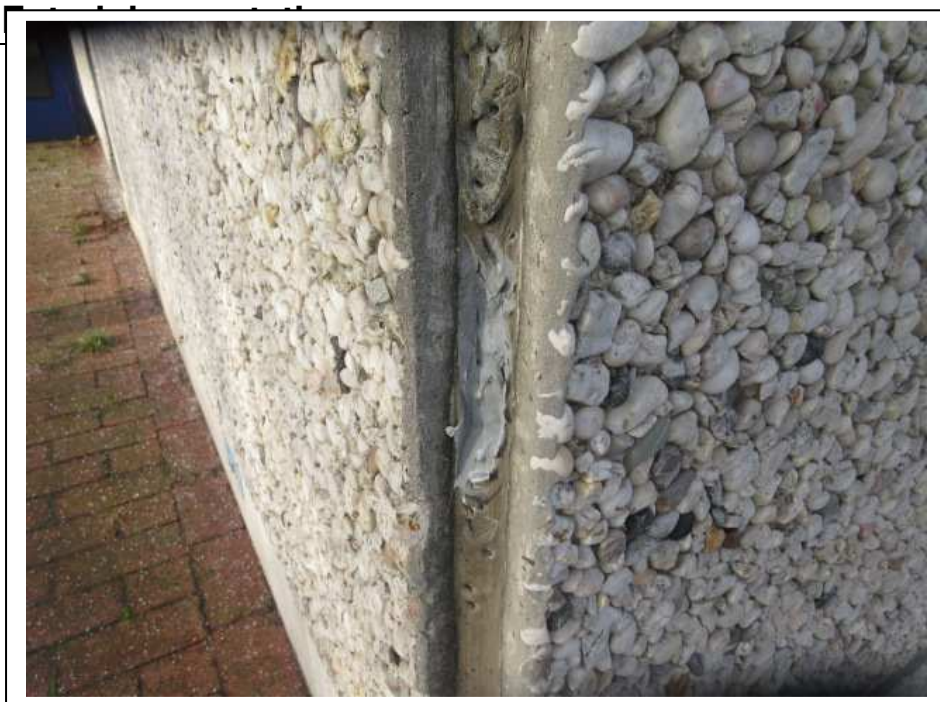
Foto 9: Waschbetonfassade, Anschlussfugenmaterial, grau, weich (Pr 160124-7)
